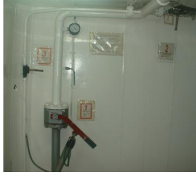
Resim 2.19: Sabit söndürme sisteminde ambar ve boyalığa giden valf
