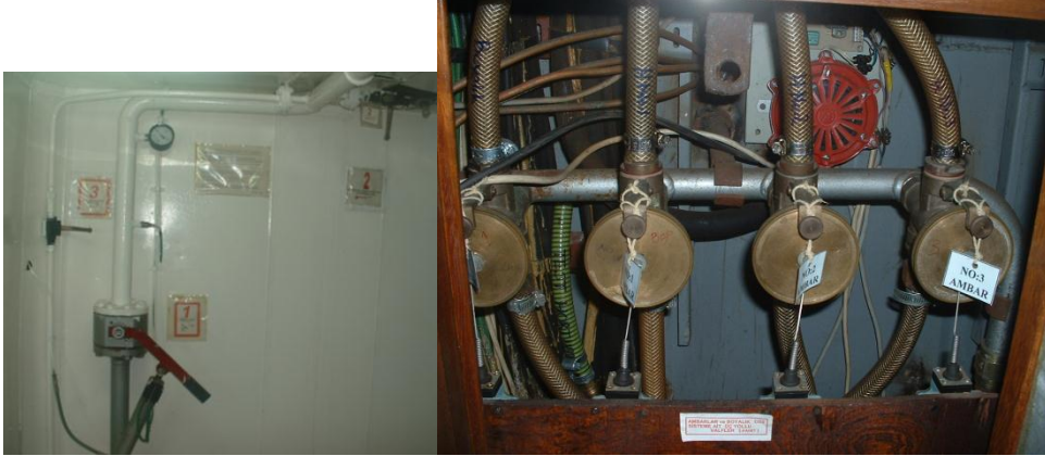
Resim 2.18: Sabit söndürme sisteminde köprüüstüne ait üç yollu valf
