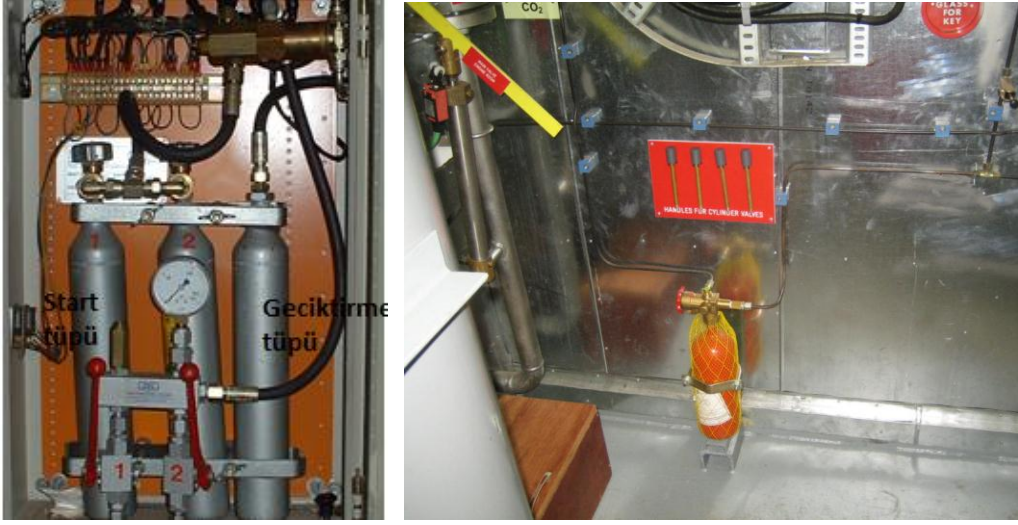
Resim 2.17: Sabit söndürme sisteminde start ve geciktirme tüpü
