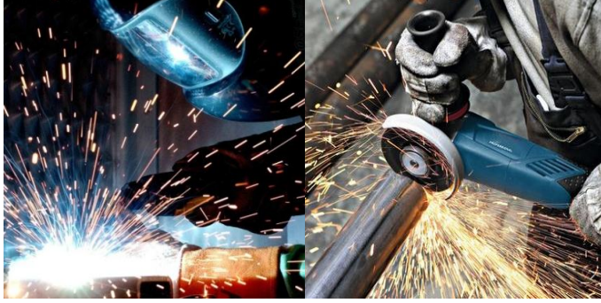
Resim 1.11: Çeşitli sıcak çalışma işleri
