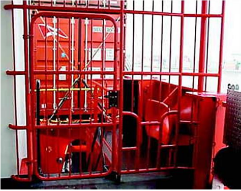
Resim 3.10: Girişi engellemek için demir parmaklıklardan yapılmış kafes ve demir kapı
