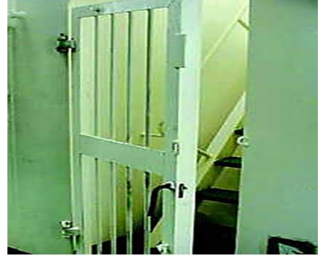
Resim 3.10: Girişi engellemek için demir parmaklıklardan yapılmış kafes ve demir kapı
